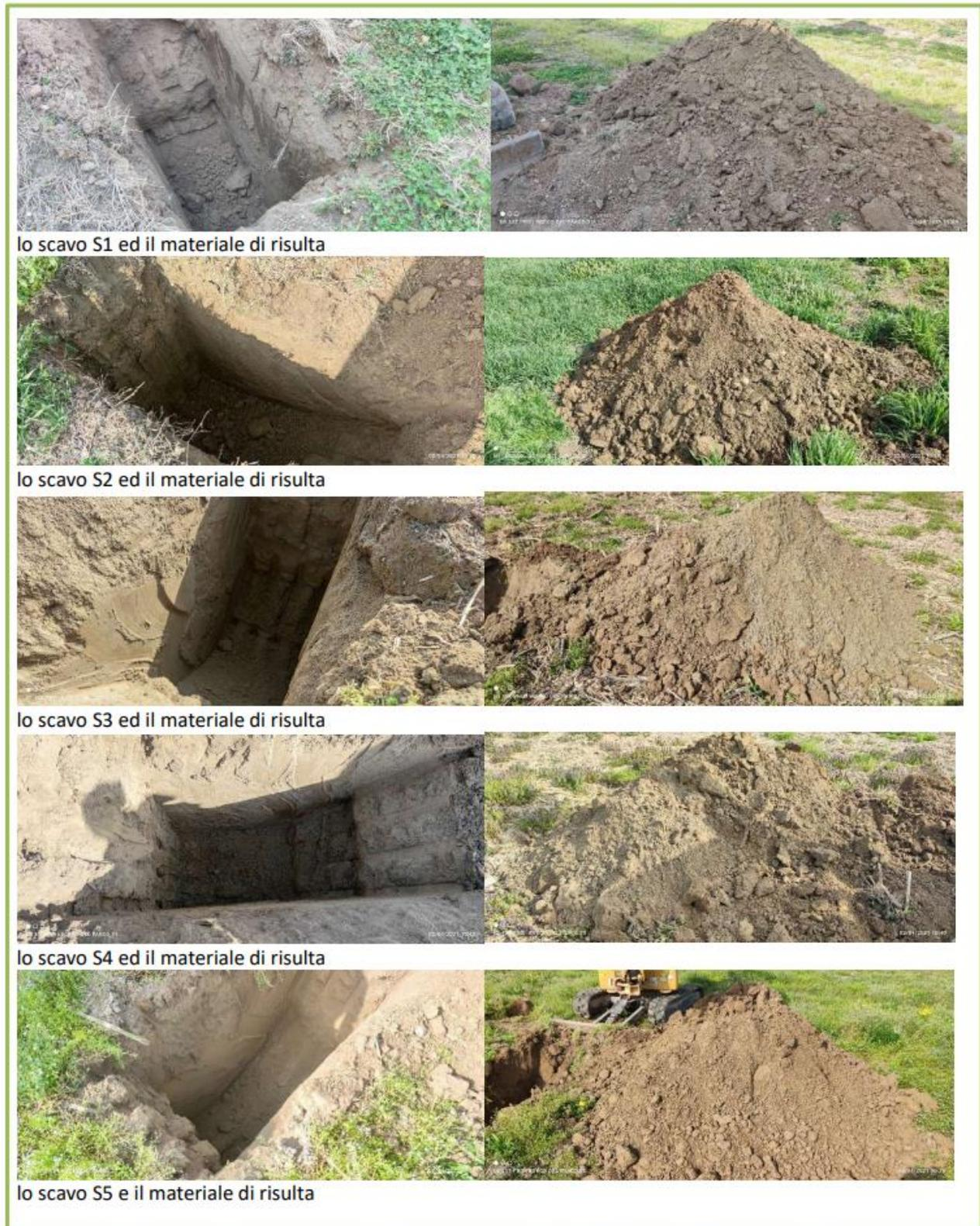
Fig. 9 – scavi per il prelievo di campioni e materiale di risulta (indagine aprile 2021)
